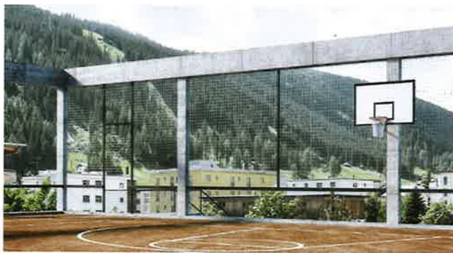
Massive Träger und Stützen charakterisieren den Dachaufbau als Gebäudeteil.
